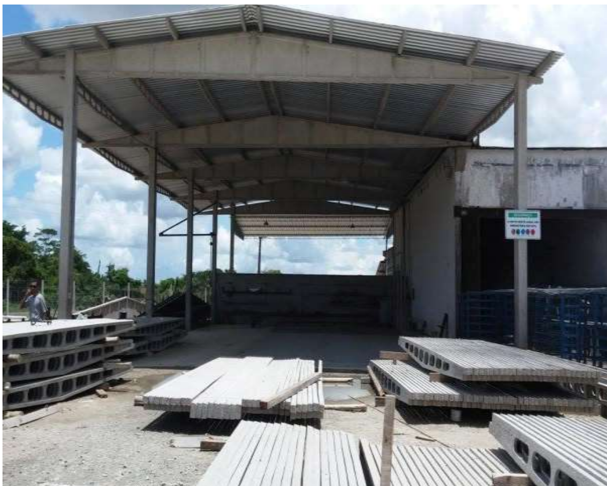
Figura 4 - Galpão setor de Concretagem
